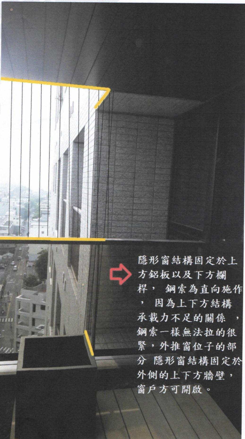
隱形窗結構固定於上方鋁板以及下方欄桿，鋼索為直向施作，因為上下方結構承載力不足的關係，鋼索一樣無法拉的很緊，外推窗位子的部分 隱形窗結構固定於外側的上下方牆壁，窗戶方可開啟。
