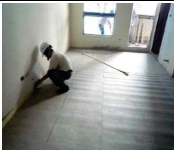
4.鋪設彈性周邊板
