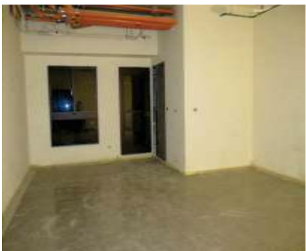
5.鋪設水泥沙漿打底層
