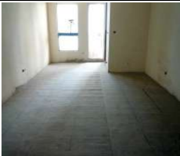
3.隔音墊鋪設完成
