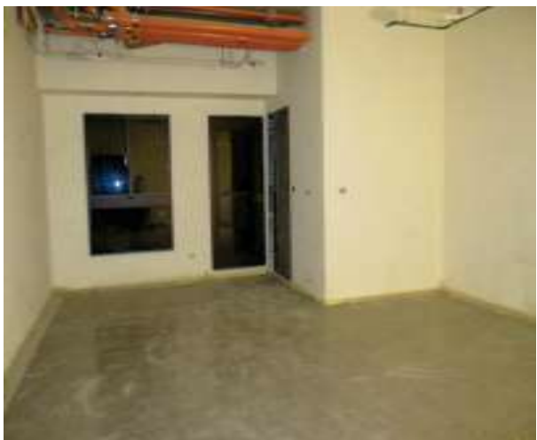
5.鋪設水泥沙漿打底層
