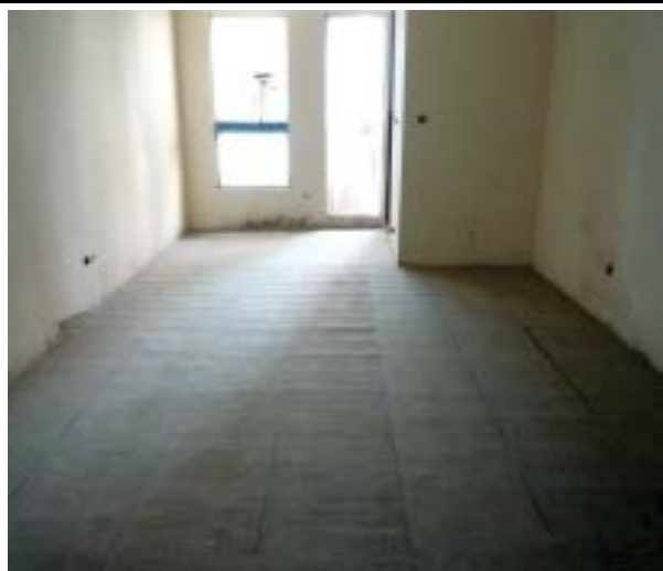
3. 隔音墊鋪設完成
