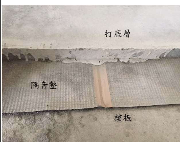
6. 鋪設完成(剖面)
