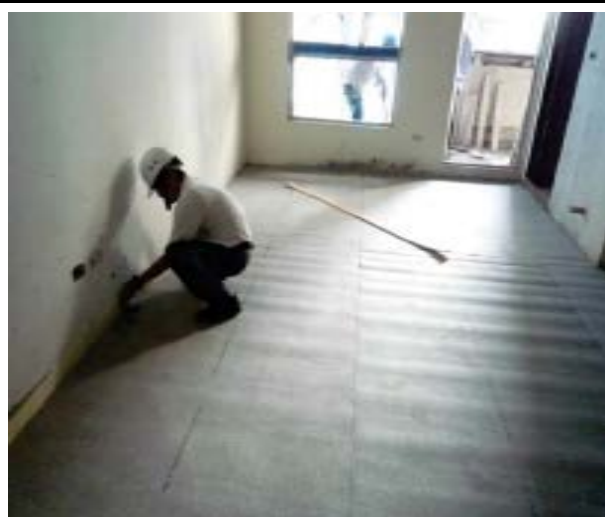
4. 鋪設彈性周邊板
