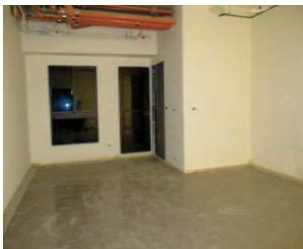
5. 鋪設水泥沙漿打底層
